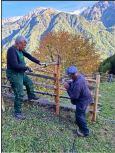
Einschlagen der Pfosten vor imposanter Kulisse.
