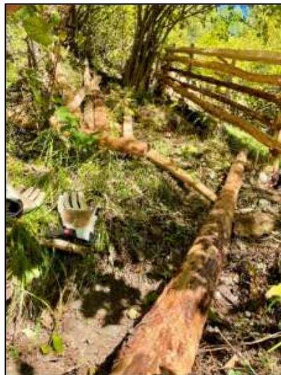
Zuvor gesägte Pfosten für die nächsten Zaunfelder.
