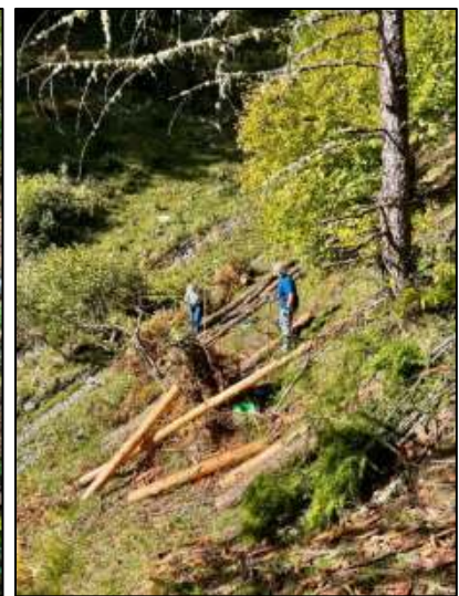
Anne und Petra auf ihrer „Baustelle“. Die „geputzten“ Stämme sind noch schön hell.
